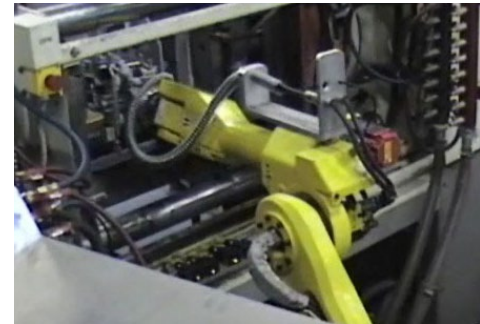
Cellule robotisée presses à injection secteur des plastiques
