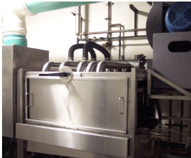
Ajout de composantes de séchages sur équipement existant
